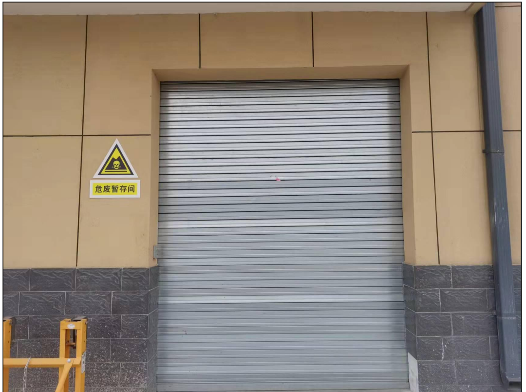
危险废物暂存间
